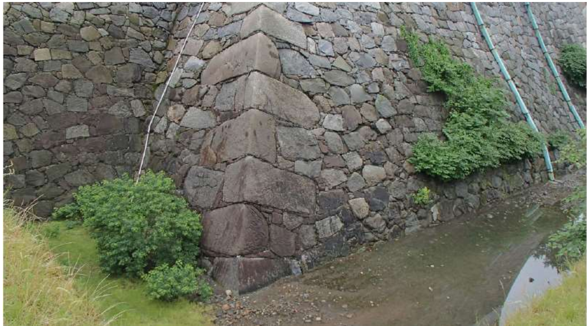
名古屋城天守台北東隅角部石垣の石積み
