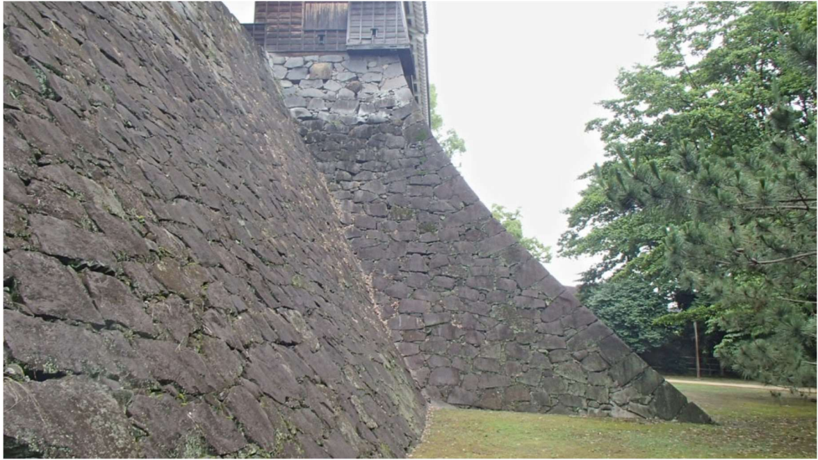
熊本城二之丸東側源之進櫓下石垣（慶長前半期）
