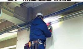
日常生活で使われる電気設備の工事を行います。図面をもとに配線や接続、機器の取り付けを行い、最後に電気が正しく流れるかを確認します。
