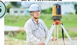
建物の位置や高さを決める測量を行って目印を設置します。その目印をもとに、ブロックをまっすぐ正しく積み上げる「ブロック積み作業」を行います。
