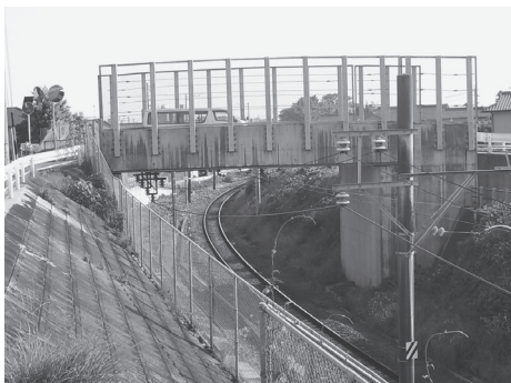
寺裏跨線橋 (小垣江町)
