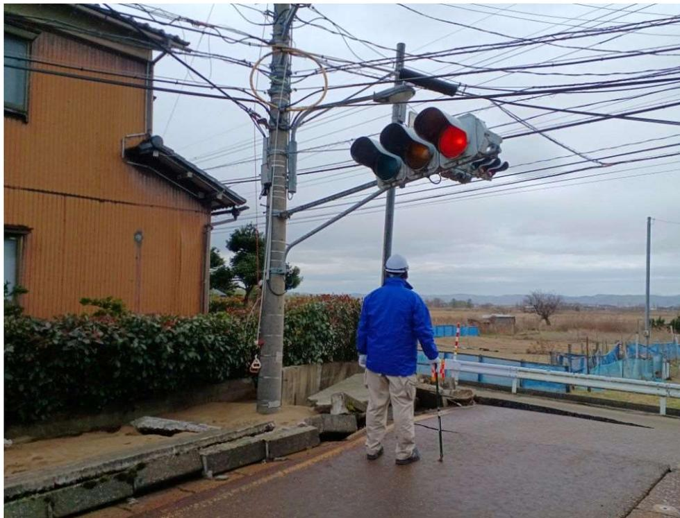
液状化により沈下した信号
