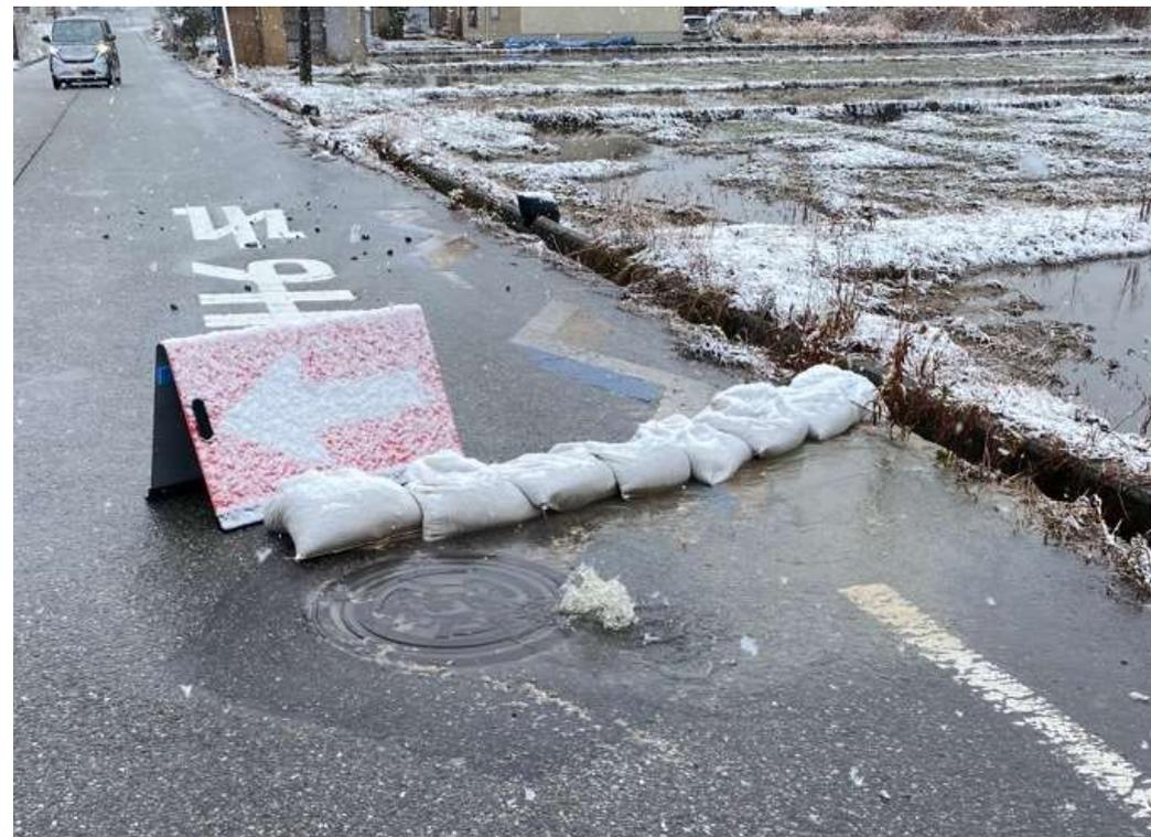
下水道管路の破損により溢れる汚水
