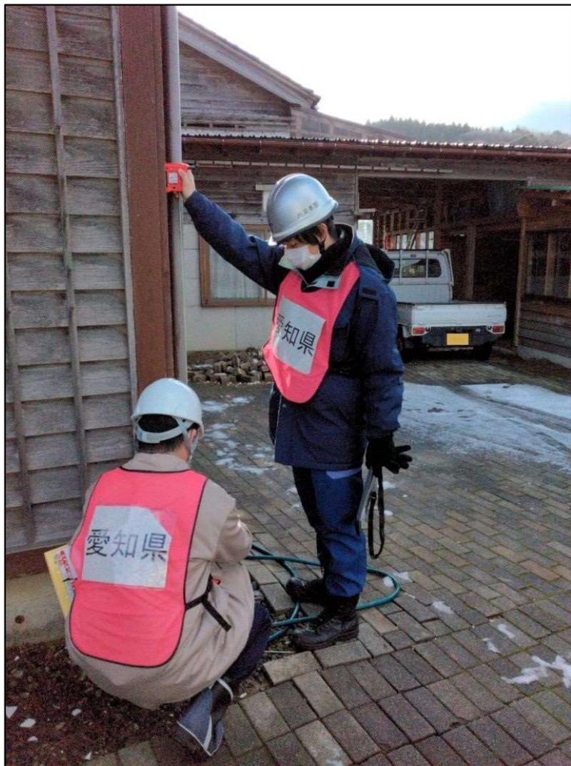
現場にて建物の傾きや損傷個所を確認
