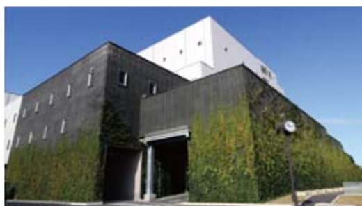
クリーンセンター(半城土町)
