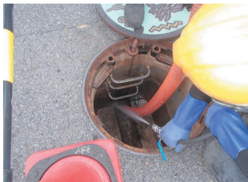
管きよ清掃（高圧洗浄）の状況
