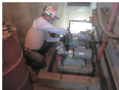
ポンプ場修繕の状況
