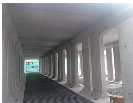
工事中の地下貯留施設の内部
