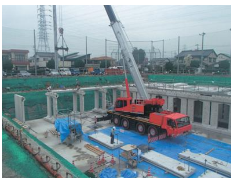
地下貯留施設の設置の様子
