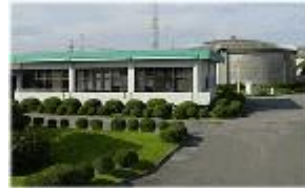
一ツ木配水場
