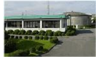
一ツ木配水場
