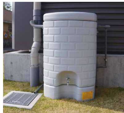
▲市役所立体駐車場に設置してある雨水貯留施設
