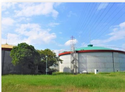
一ツ木配水場 配水池
