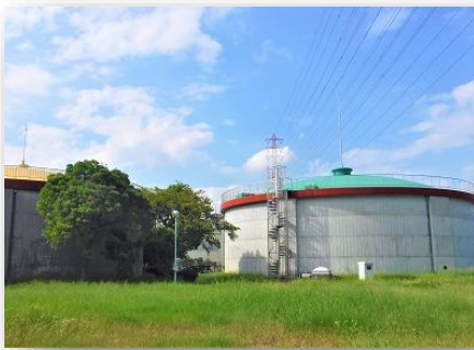
一ツ木配水場 配水池
