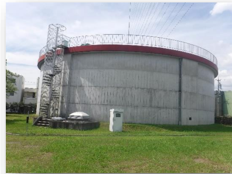
一ツ木配水場 県水 3号配水池
