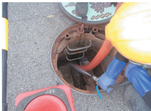
管きよ清掃（高圧洗浄）の状況
