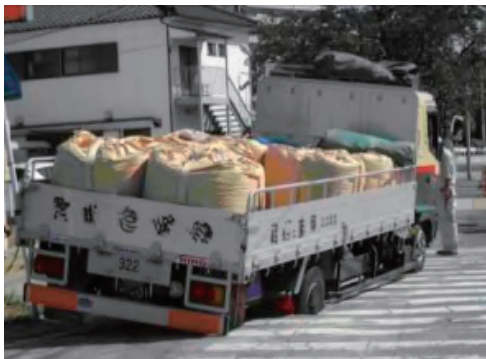
管路施設※に起因した陥没事故例（他自治体）
