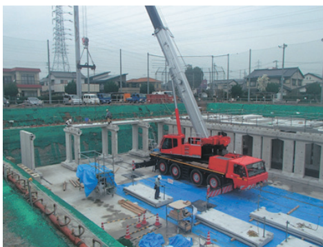
地下貯留施設の設置の様子
