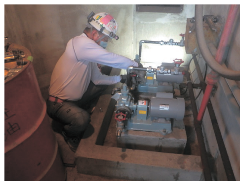
ポンプ場修繕の状況
