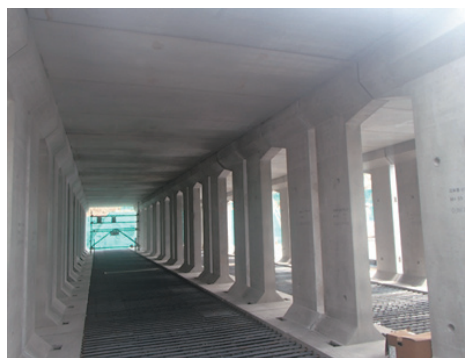
工事中の地下貯留施設の内部
