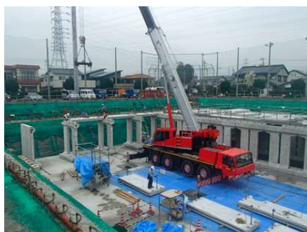
地下貯留施設の設置の様子
