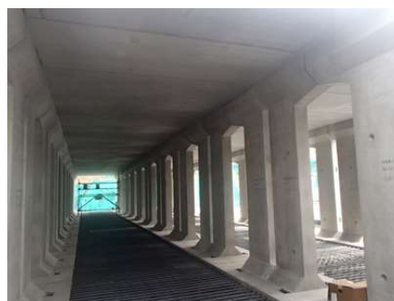
工事中の地下貯留施設の内部
