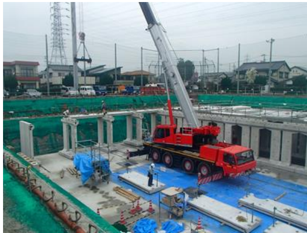
地下貯留施設の設置の様子
