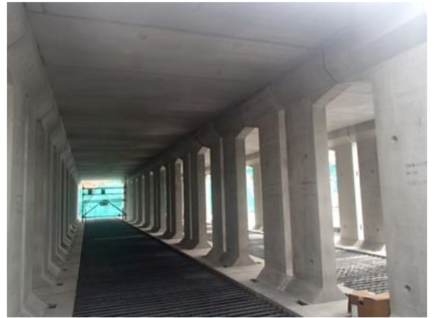
工事中の地下貯留施設の内部
