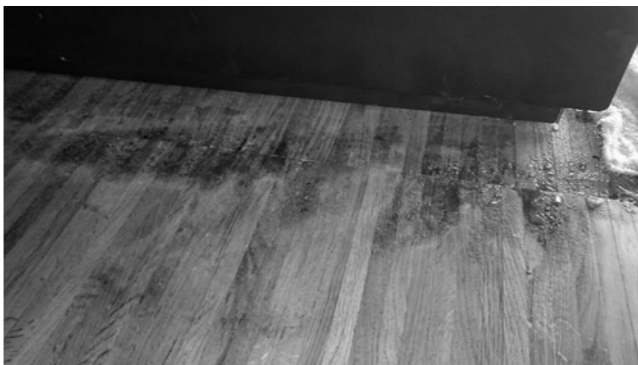
(写真2) 結露による床への浸透
