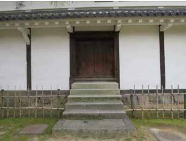
福山城伏見櫓出入口板大戸(引戸)
