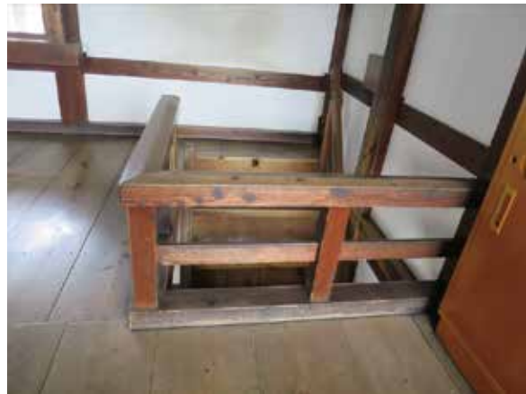
階段上部手摺（姫路城）
