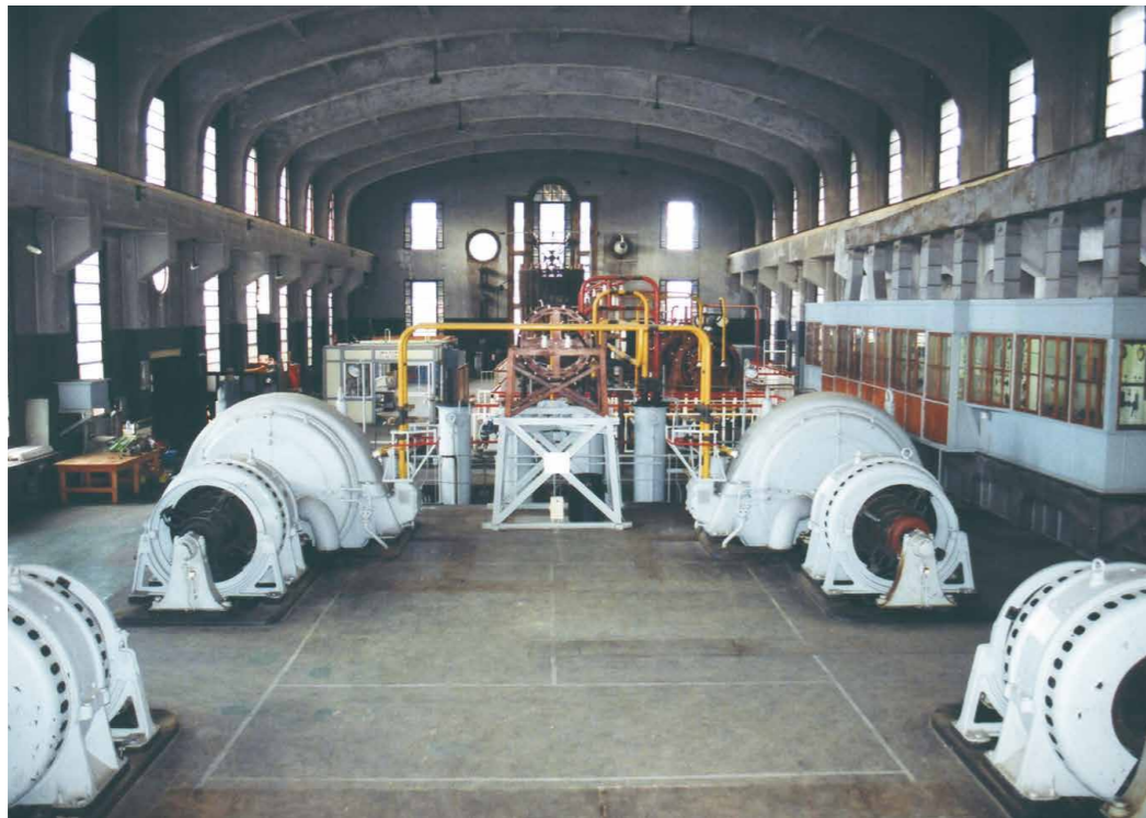
解体前の送信室内
