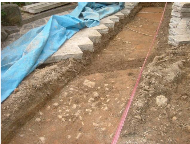
写真5 第5トレンチ上段 建物基礎列
