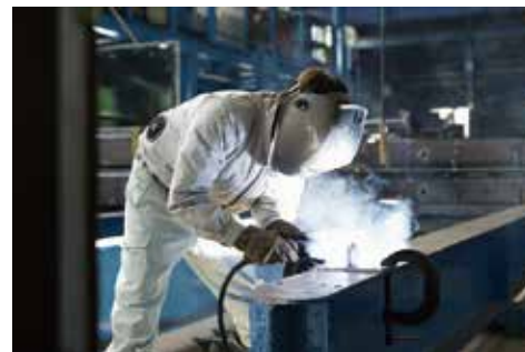
制作状況： 弊社工場での水門の制作現場の写真です。
