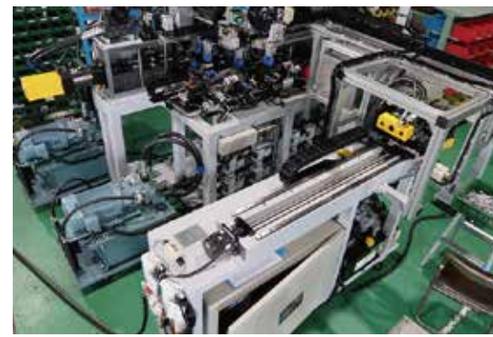
パイプ端末加工～ナットを自動挿入 ～反対側の端末加工～端末加工部の外径検査 ～CNCパイプベンダーでの曲げ自動ライン
