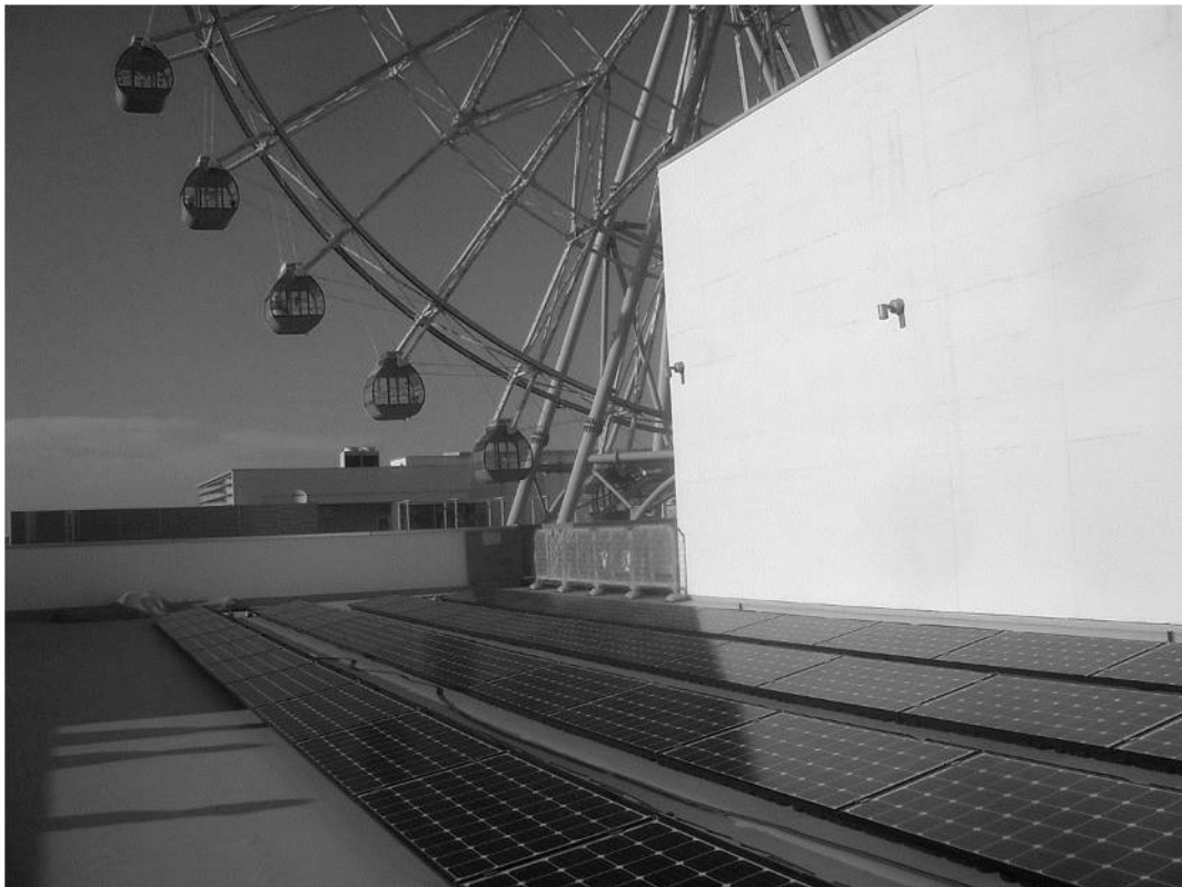
図 4.8 刈谷ハイウェイオアシスに設置された太陽光発電システム
