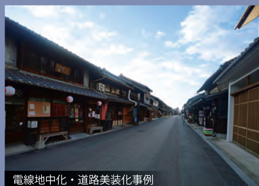
電線地中化・道路美化事例
