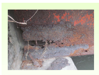
防護柵の損傷
