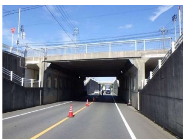
一ツ木大橋南地下道
