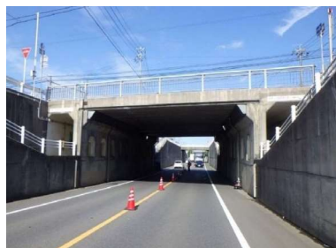
一ツ木大橋南地下道
