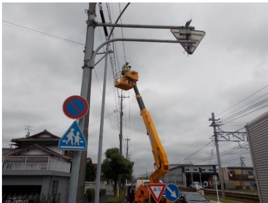
高所作業車による近接目視点検
