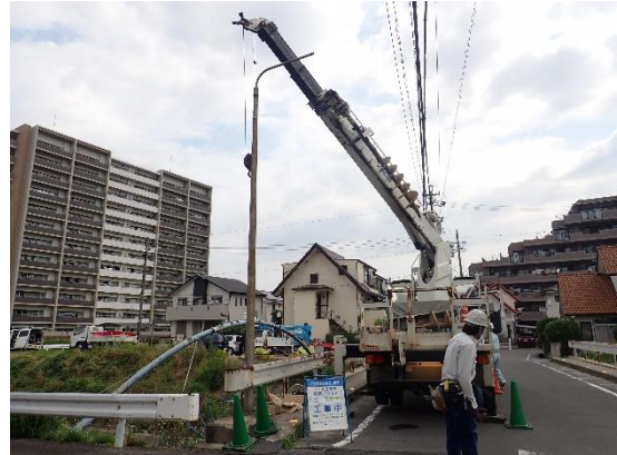
更新時の作業状況
