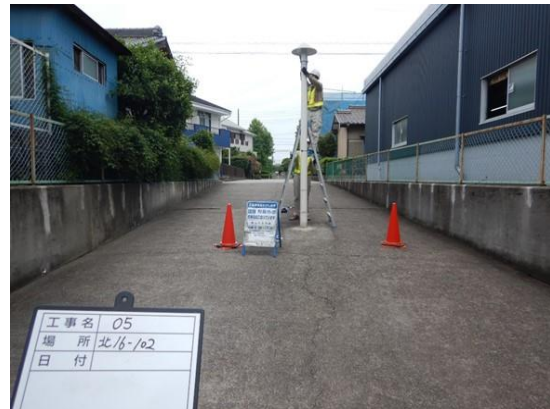
脚立による近接目視点検
