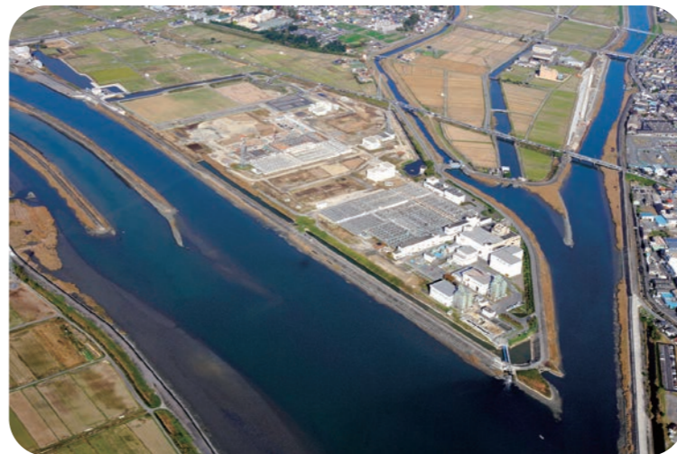
境川浄化センター
