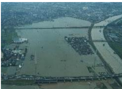
■東海豪雨での被害状況
