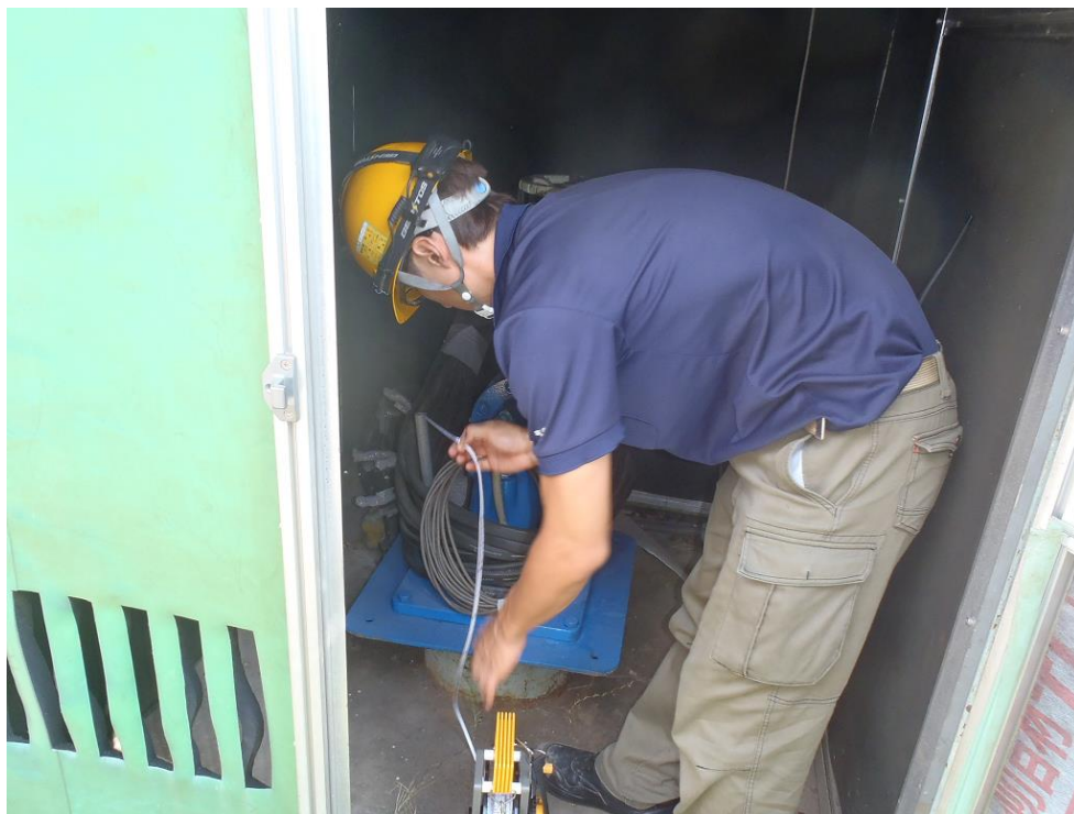
地下水位調査
