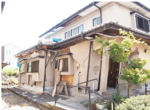
▲外壁の剥離、柱の傾き
