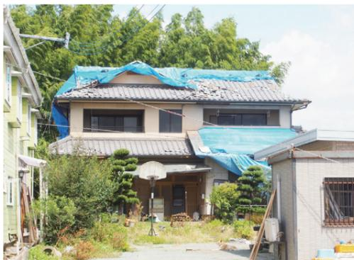
▲屋根瓦の破損、落下
