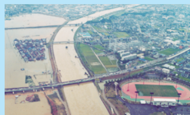
▲豪雨により増水した逢妻川
