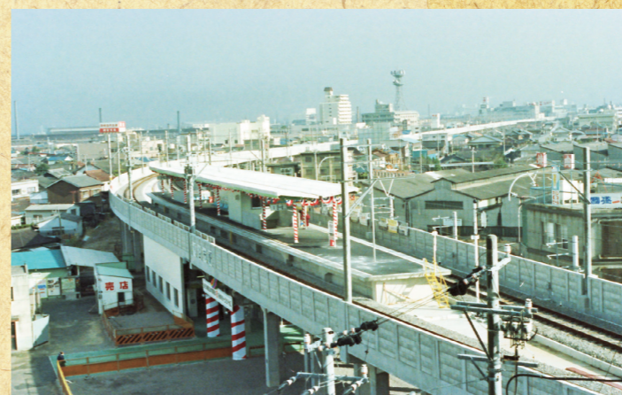
1980(昭和55年) 名鉄三河線高架が完成
