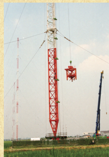
1996(平成8年) 依佐美の鉄塔解体工事が始まる
