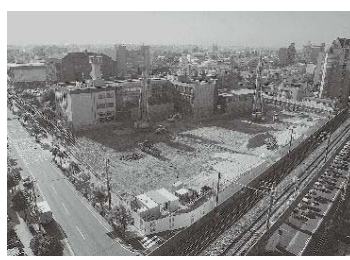
建設工事中の新庁舎
