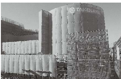
建設の進む刈谷市総合文化センター
