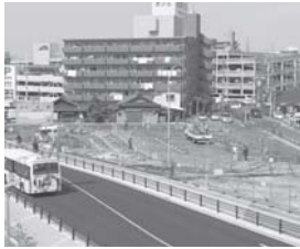
整備される南口駐車場
