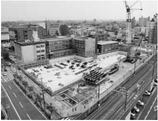
建設工事が進む新庁舎
