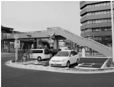
刈谷駅北口広場駐車場
