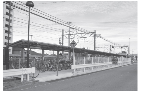
一ツ木駅南口に駐輪場を整備
