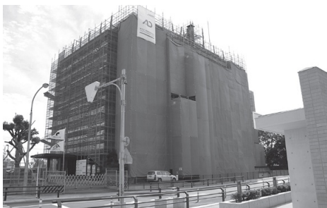
改修中の市役所旧南庁舎
