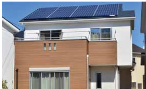
自然エネルギーの有効活用 (太陽光発電)
