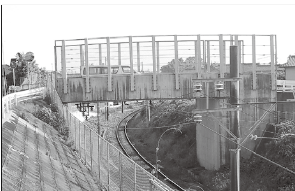
安全に避難所へ 寺裏跨線橋（小垣江町）
