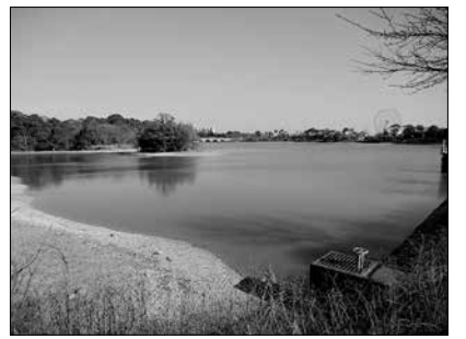
防災ダム事業が進む岩ヶ池
