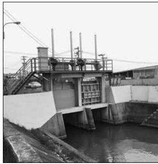
整備中の前川左岸樋門
