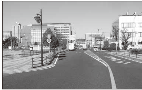
改良中の市道01-25号線 (東陽町)
