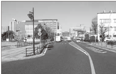
改良中の市道01-25号線(東陽町)
