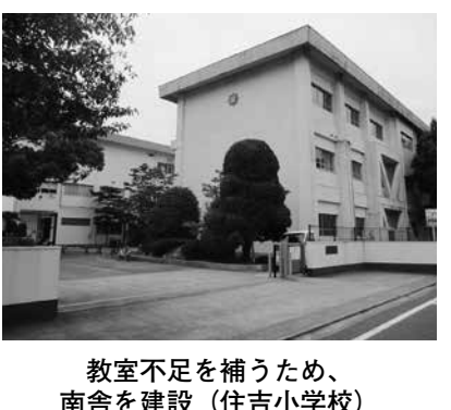
教室不足を補うため、南舎を建設(住吉小学校)
