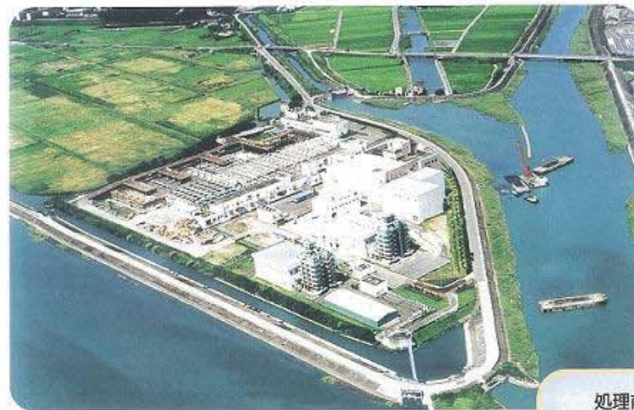
境川浄化センター
