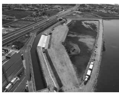
現在、5年確率降雨に対応する整備が行われている準用河川草野川
