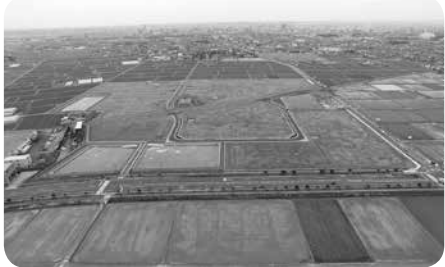
整備が完了し、引渡しが始まる刈谷依佐美地区の先行開発区域
