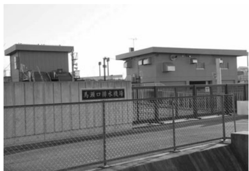
馬瀬口排水機場 (今川町)
